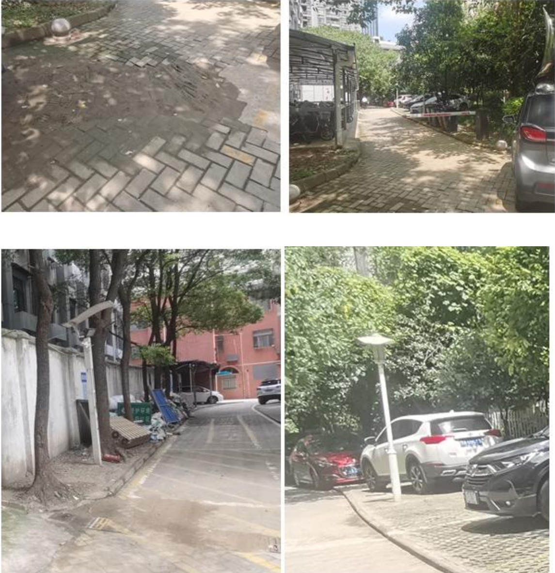
图 3.5 道路及停车现状
