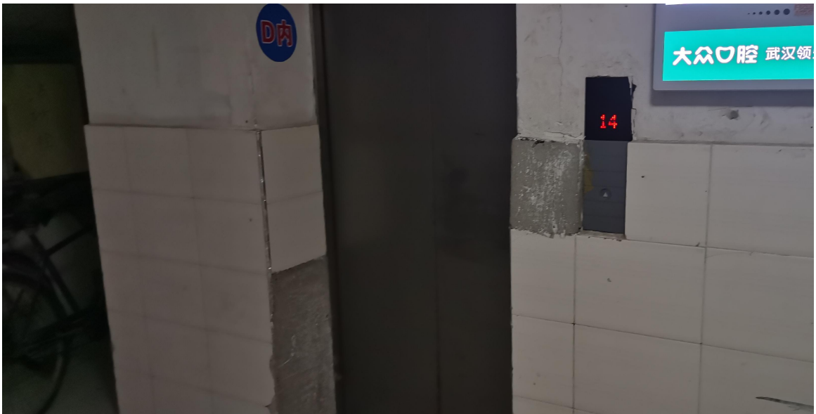
图 3.16 建筑本体现状
